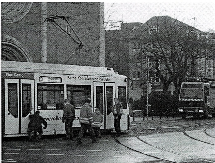
Beachtenswert: Die Wiedereingleisungsarbeiten begannen bei angebügelter Stromabnahme Foto: Christoph Heine
