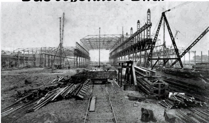
Baustelle des Ausbesserungswerkes Braunschweig ca. 1926. In Bildmitte, entsteht grade die Richthalle des Werkes, Blickrichtung Westen. Links im Bild ist die Kesselschmiede zu erkennen. Rechts hinten im Bild das Verwaltungsgebäude des Werks, selbst heute noch mit derselben Adresse: Borsigstraße 1. Bild: Crayen, Sammlung Marc Lewandowski
