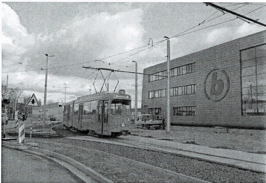
Tw 41 vor dem neuen Betriebsgebäude.
