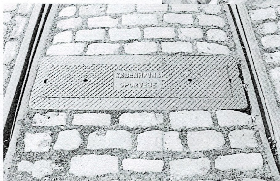
Viele Details sind zu entdecken: Hier eine originale Abdeckung eines Weichenantriebs der Kopenhagener Straßenbahn
