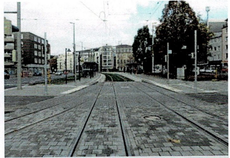
Statt Vorsortiergleis, jetzt eine Weiche vor der Kreuzung J.-F.-Kennedy-Platz in Richtung Lessingplatz
