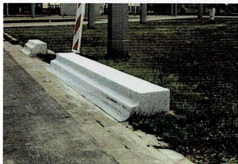
Dieser Typ Hochbord ist für den Omnibussektor vorgesehen.
